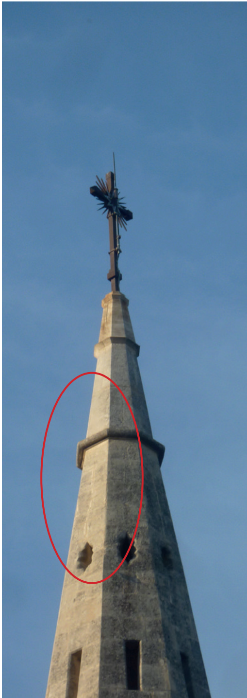
Figure 3 : Menuiseries du clocher très hétérogènes. Certaines parties remplacées, abat-sons d'origine vétustes ; teintes non harmonisées...
