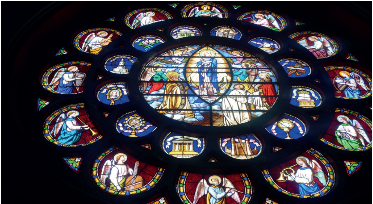
Figure 1 et 2 : Rose de la nef en bon état général ; les vitraux protégés par une raquette extérieure en verre ont été protégés des intempéries.
