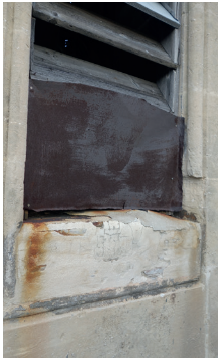
Figure 4 : Vue des appuis de la structure. Les tableaux des baies ont été adaptés pour permettre l'installation d'une structure métallique
