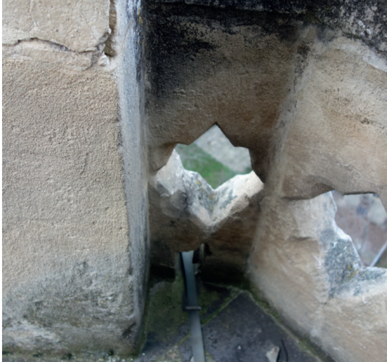
Figure 3 : Vue générale du clocher nord. Encrassement général, lessivage des parements et forte humidité sous les machicoulis
